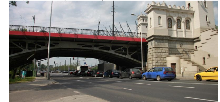
Widok na most Poniatowskiego wraz z zejściem pieszym od strony południowej
