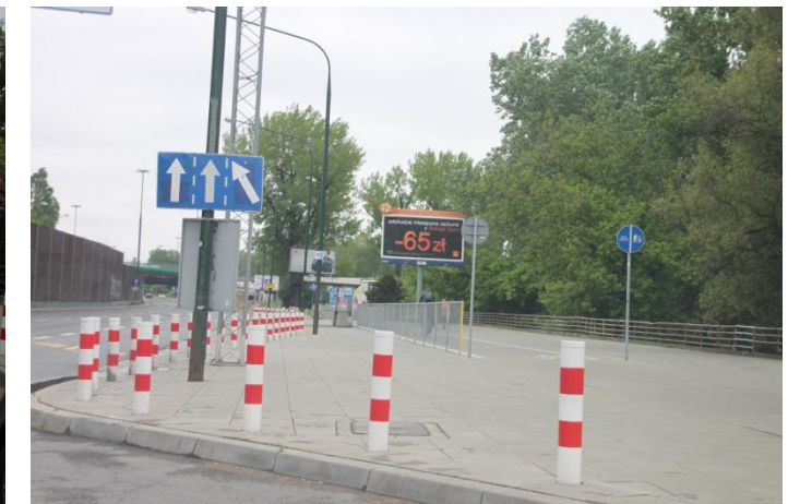
Widok na rejon w. z Trasą Łazienkowską i rekomendowane dowiązanie do istniejącej trasy rowerowej.
