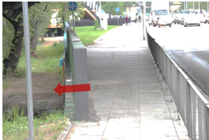
Widok na zwężenie chodnika w rejonie m. Poniatowskiego - możliwe rozwiązanie ruchu pieszego i rowerowego poprzez poszerzenie dzięki przesunięciu muru oporowego
