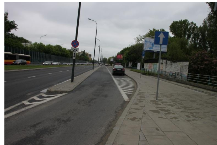
Widok na jezdnię manewrową do wykorzystania na trasę rowerową - dopuszczenie dwukierunkowego ruchu rowerowego.
