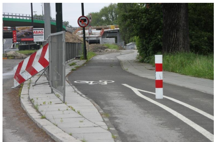
Widok na istniejącą trasę rowerową przechodzącą po zachodniej stronie węzła z Trasą Łazienkowską
