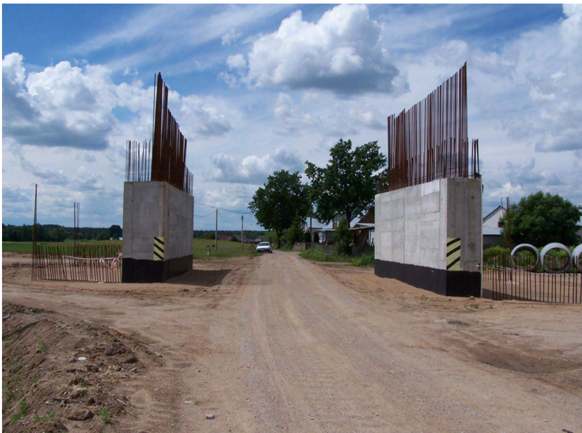
Fot. 10. Budowa wiaduktu na trasie wariantu nr I koło wsi Gatno – czerwiec 2008.
